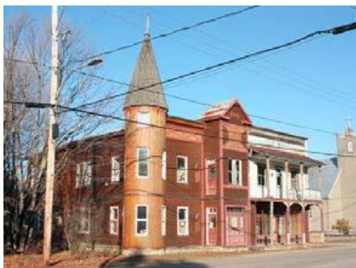
Résidence 345, route des Cantons
