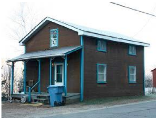
Résidence 317, route des Cantons
