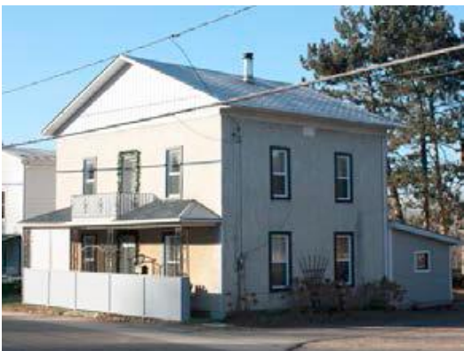
Résidence 331, route des Cantons
