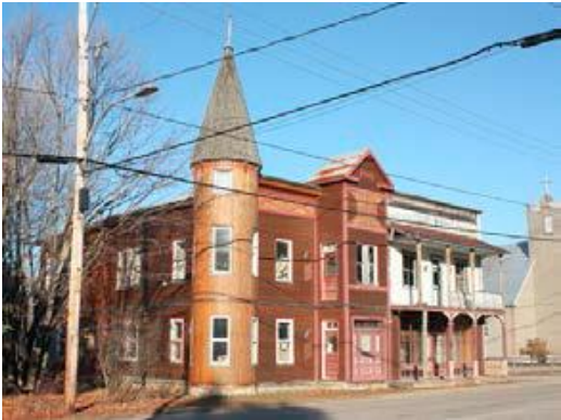
Résidence 345, route des Cantons
